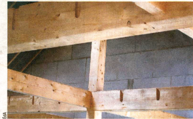
La Compagnie du Bois assemble des poutres «industrialisées à l'ancienne». Ni clou, ni vis... des queues-d'aronde.
